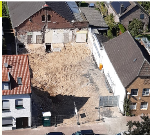
Abriss alter Drei-Kronen-Hof
